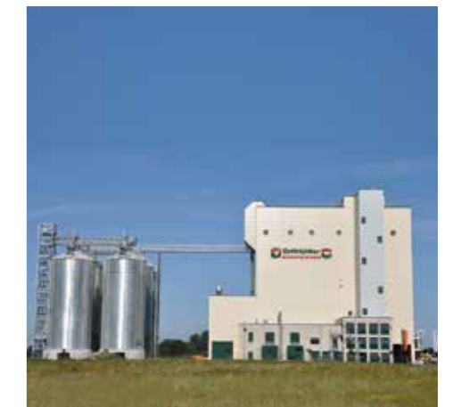
Rothkötter Mischfutterwerk, Germany Feedmill 50 T/H
